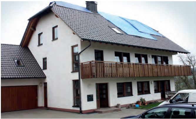
Bild 2 | Übersichtsaufnahme des schadenbetroffenen Zweifamilienhauses. Unter der Plane befinden sich die Solarkollektoren.
