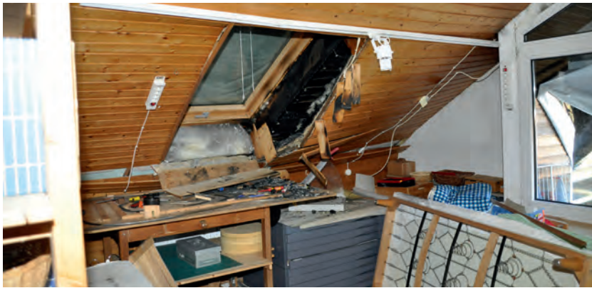
Bild 4 | Blick in das Atelier: Neben dem Dachflächenfenster waren auf dem Dach die ersten Flammen erkennbar.
