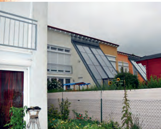
Bild 6 | Blick auf ein baugleiches Nachbargebäude des schadenbetroffenen Doppelhauses
