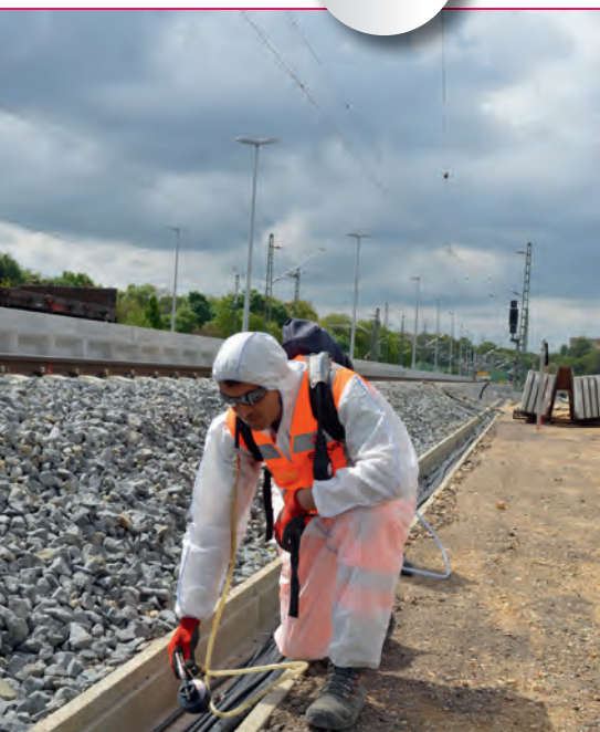
Bild 4 | Ein Arbeiter markiert Kabel an Gleisanlagen der DB AG mit künstlicher DNA. Der Anzug schützt dabei nur vor Verschmutzung.
