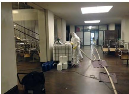
**Bild 2** | Desinfektion des Bodenaufbaus mittels Wasserstoffperoxid-Peressigsäure, die im Falle des Olympiastadions in 1.000 Liter fassenden Cubitainer verdünnt wurde (3%)
