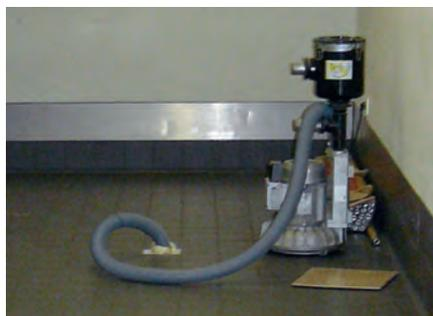
**Bild 3 und 3a** | Das Vakuumverfahren wird zur Trocknung von schwimmenden Estrichen eingesetzt. Die Trocknung erfolgt in zwei Phasen: In der ersten Phase wird das Wasser über eine Vakuumpumpe flüssig, in der zweiten Phase dampfförmig abgesaugt.
