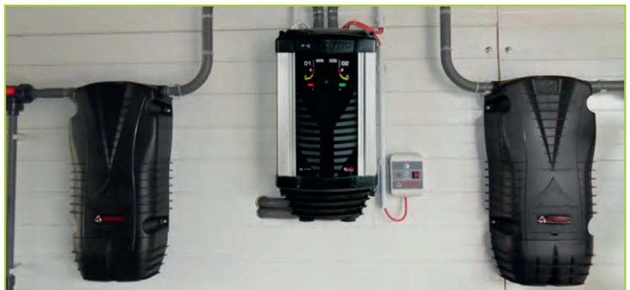
**Bild 6** | Elotec Ansaugmelder mit Filtertechnik – geringe Anschaffungskosten, hohe Sicherheit
