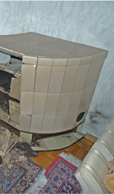
Bild 4 | Fall 3 | Durch die Explosion wurden die gemauerten Warmluftauslässe gesprengt.
