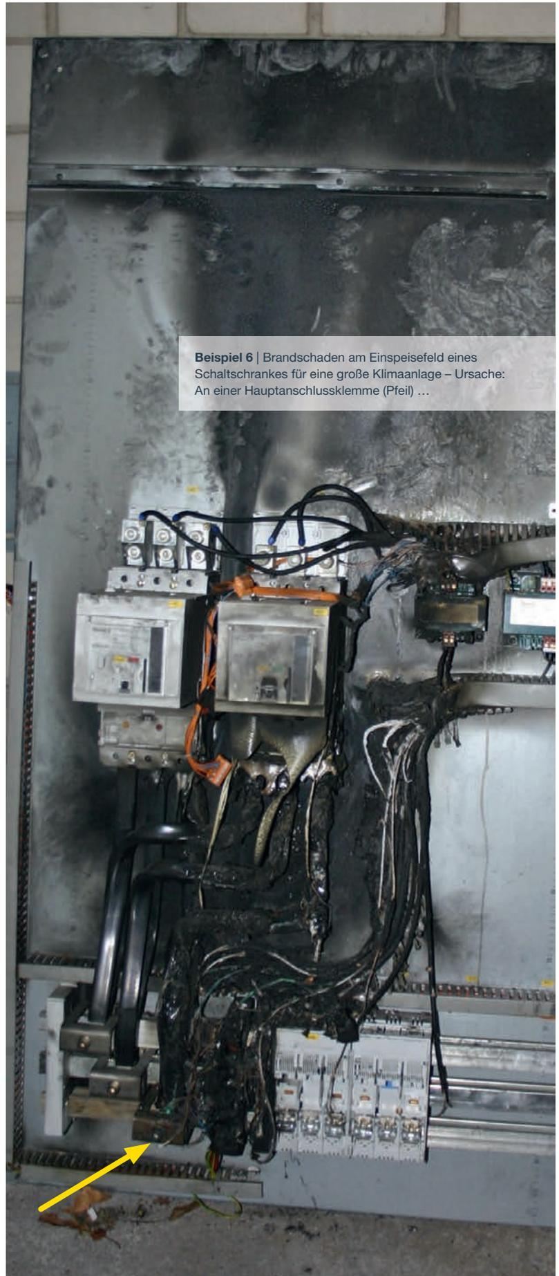
**Beispiel 6** | Brandschaden am Einspeisefeld eines Schaltschrankes für eine große Klimaanlage – Ursache: An einer Hauptanschlussklemme (Pfeil) ...
