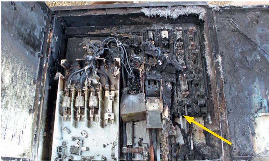
**Beispiel 5** | Totalverlust eines Einspeiseschrankes einer größeren Photovoltaikanlage – Ursache: Die Aluminiumader (Pfeil) einer Haupteinspeiseleitung ...
