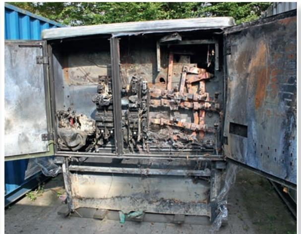
**Beispiel 7** | Totalverlust einer 630-kVA-Mittelspannungs-transformatorenstation – Ursache: Im Bereich der Niederspannungs-verteilung ...
