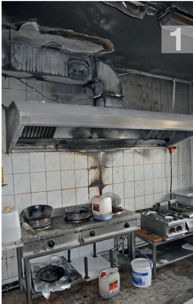
Bild 1 | Blick auf den Gasherd, die Dunstabzugshaube und den darüber verlaufenden Abluftkanal
