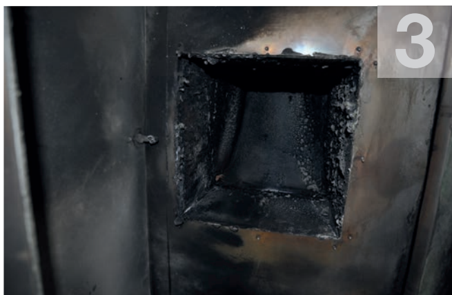
Bild 3 | Im Einlass des Abluftkanals sind verbrannte Reste von Fettablagerungen zu sehen.
