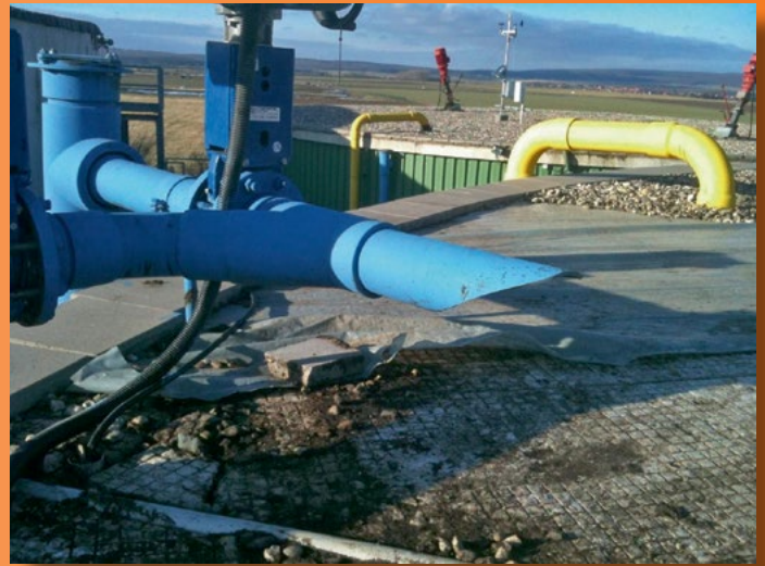
Bild 4 | Geborstene Leitung durch Frost
