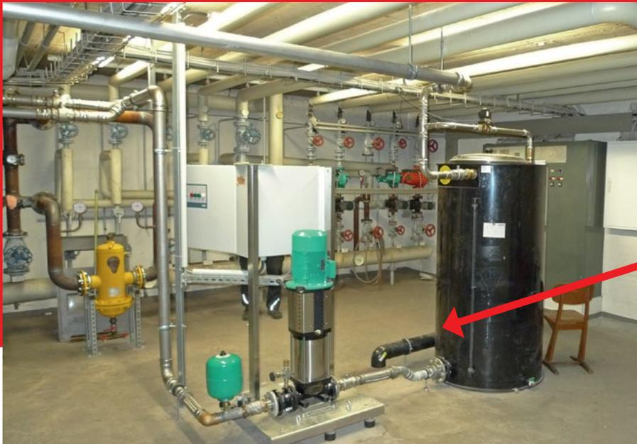
**Bild 1** | Die Druckerhöhungsanlage mit dem schwarzen Vorratsbehälter, dessen Überlaufrohr direkt über einem Bodeneinlauf mündet
