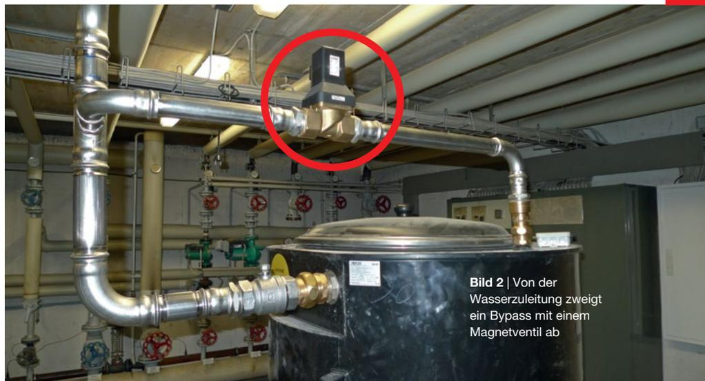
**Bild 2** | Von der Wasserzuleitung zweigt ein Bypass mit einem Magnetventil ab
