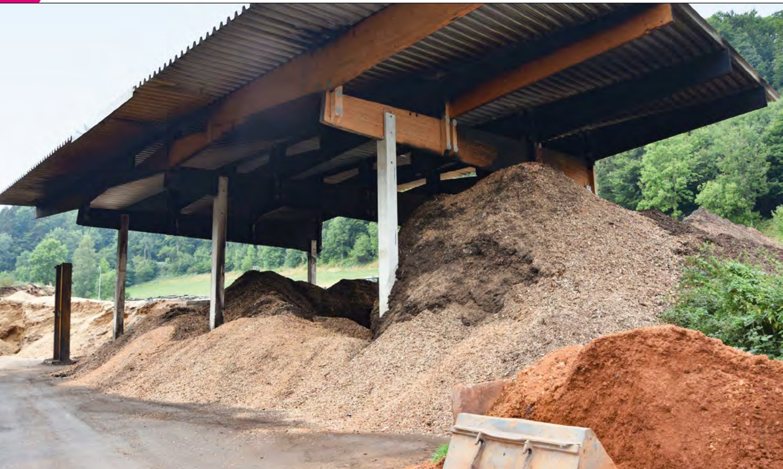
Bild 7 / Das vom Brand betroffene überdachte Hackschnitzellager. Hier kam es aufgrund hoher Lagerhöhen (etwa 7 - 10 Meter) zur Selbstentzündung des Hackgutes.
