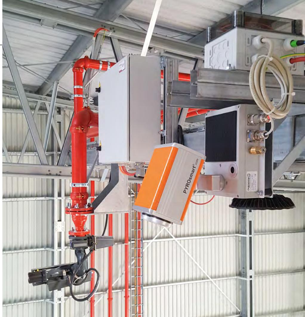
**Bild 4 /** Infrarotkamera mit Löscherwerfer
