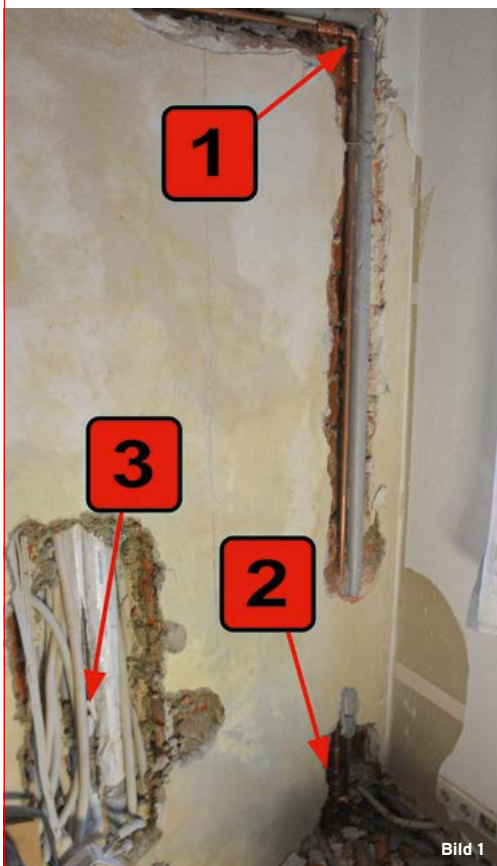
Bild 1 / Die Wand ist an den drei Leckagestellen geöffnet. Rechts: Nahaufnahme der getrennten Trinkwasserleitung, die links mit der Nummer 3 markiert ist.
