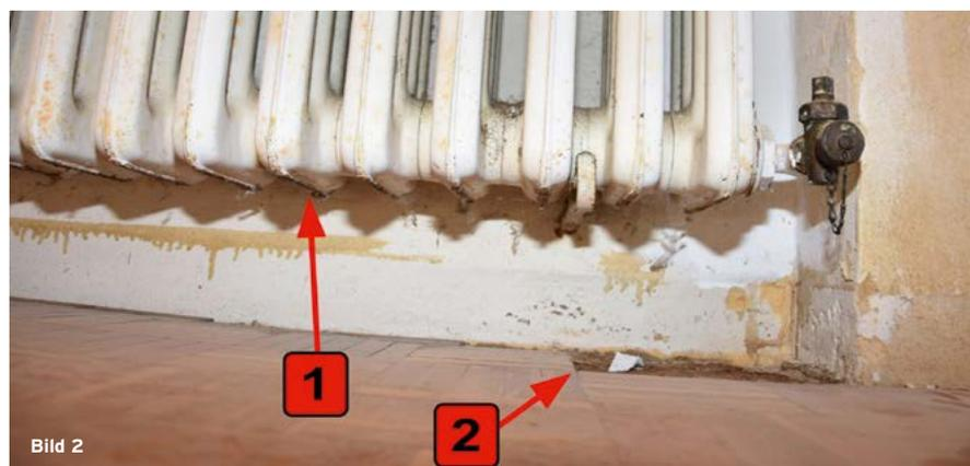
**Bild 1 /** Aus dem Heizkörper im Gästezimmer ist ein Teilstück herausgebrochen (1). Es liegt zum Ortstermin auf der Fensterbank (2). **Bild 2 /** Im Wohnzimmer ist der Heizkörper an der Unterseite gerissen (1). Das Parkett zeigt Feuchtschäden (2).
