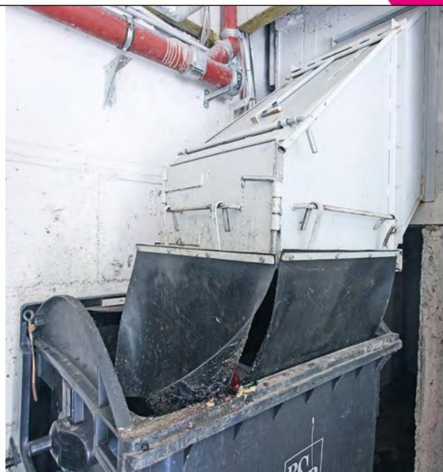
Bild 1a+b / Keine Mülltrennung am Sammelbehälter unterhalb des Abwurfschachtes
