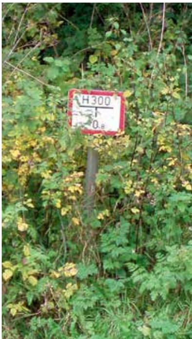
ben zeigen schnell, um welchen Hydranten es sich handelt. Rot steht für Hydranten mit einem Durchmesser bis 100 mm, Grün für alle zwischen 125 und 200 mm und Blau für und alle ab 250 mm.
