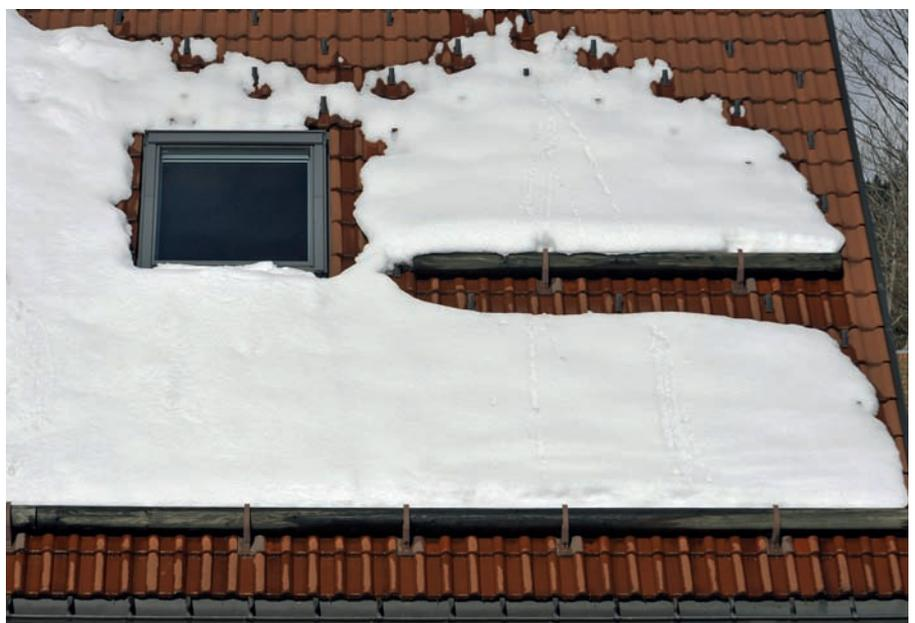
**Bild 23** | Schneefangbalken verhindern ein Abrutschen des Schnees („Dachlawinen“). Foto: Bamberger
