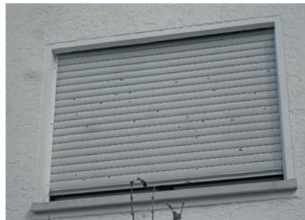
**Bild 15** | Beschädigter Rollladen
