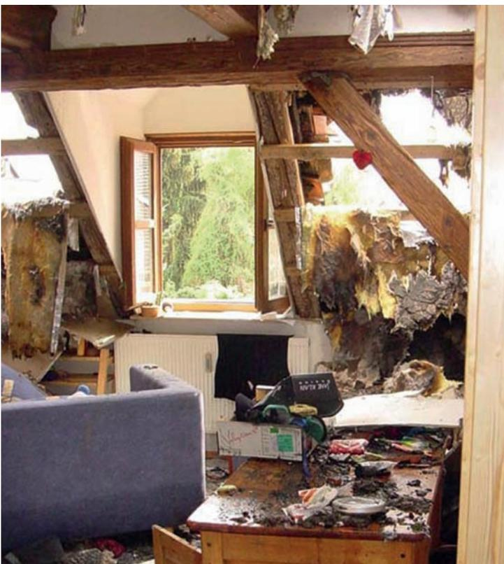
Bild 4 bis 8 | Das aufwendig renovierte Gebäude wurde insbesondere durch das Löschwasser im Decken- und Fußbodenbereich erheblich beschädigt.
