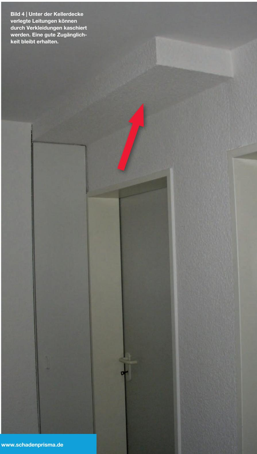
Bild 4 | Unter der Kellerdecke verlegte Leitungen können durch Verkleidungen kaschiert werden. Eine gute Zugänglichkeit bleibt erhalten.
