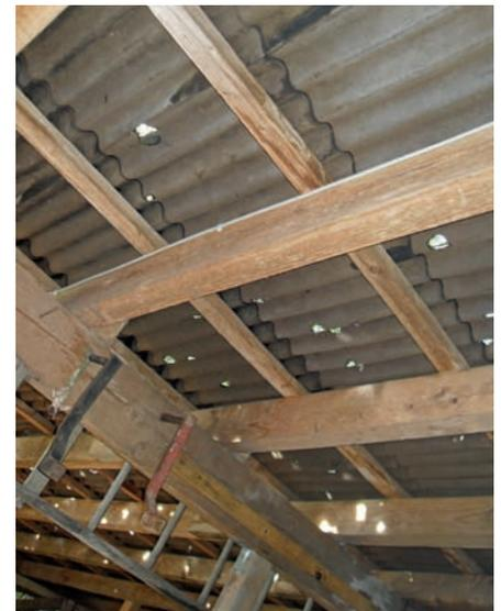
**Bild 17** | Bitumenwellplatten durchsiebt
