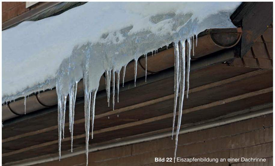
**Bild 22** | Eiszapfenbildung an einer Dachrinne
