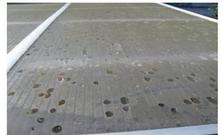
**Bild 16** | Beschädigte Doppelstegplatten einer Pergola
