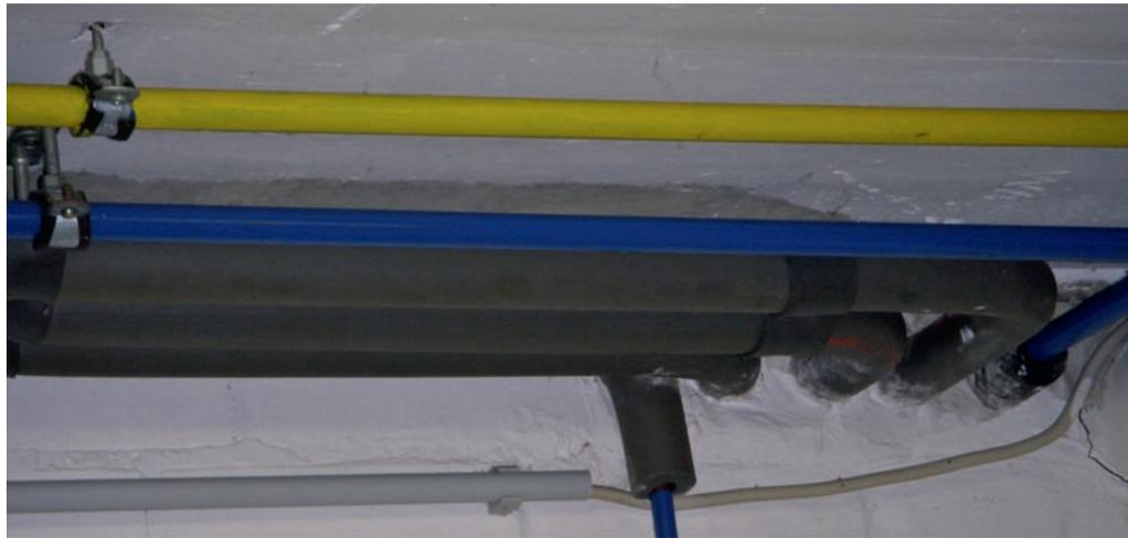
**Bild 2** | Unter der Kellerdecke verlegte Leitungen bieten eine gute Zugänglichkeit.
