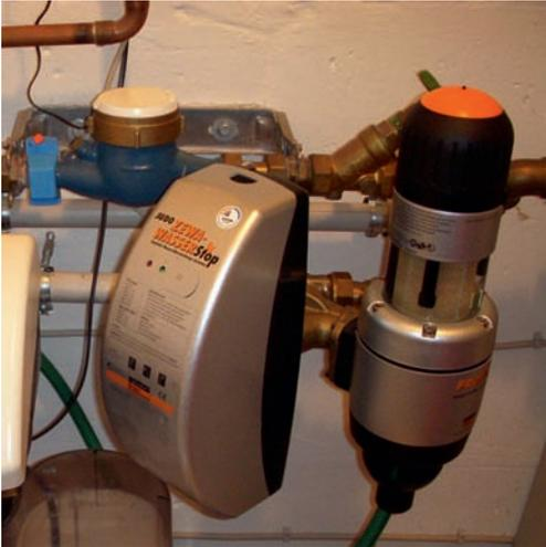
**Bild 7** | Ein zweites Beispiel für empfehlenswerte Installationstechnik mit Feinfilter und Leckagedetektor
