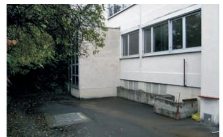
Bild 10 | Schutz von Kellerfenstern durch Ummauerung
