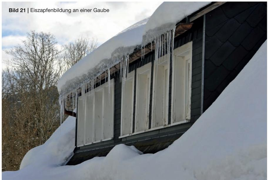
**Bild 21** | Eiszapfenbildung an einer Gaube
