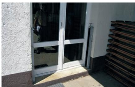
**Bild 13** | Schutz von tief liegendem Hauseingang (Schienen als Führung und Halterung für mobile Hochwasserbalken). Foto 13–17: Bamberger
