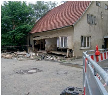
Bild 9 | Zerstörungen durch Hochwasser
