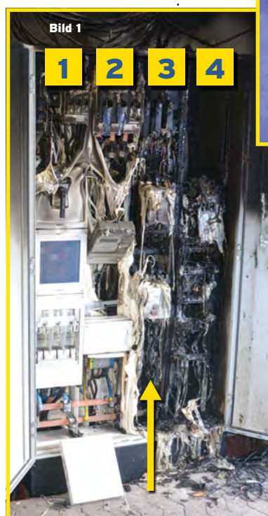
Bild 1 / Der brandbetroffene Verteilerschrank verfügte über vier Reihen. Unten in Reihe 3 (Pfeil) befanden sich die Klemmen der PV-Anlage. Dort entstand der Brand.
