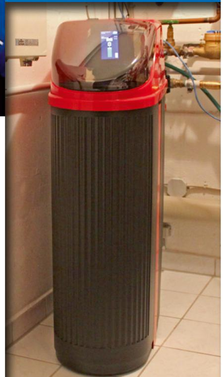
**Bild 6** | Enthärtungsanlagen müssen regelmäßig gewartet werden.
