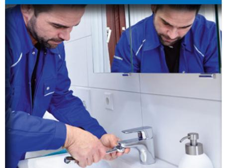
**Bild 7** | Der Luftsprudler am Einhebelmischer wird im Rahmen einer Wartung herausgeschraubt und gereinigt.
