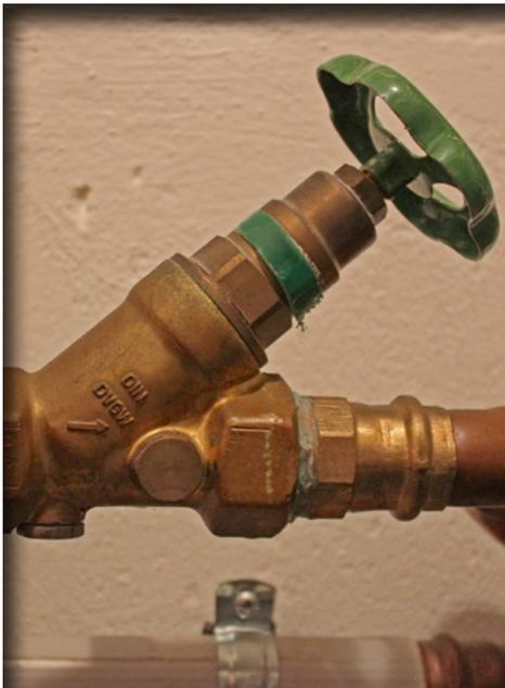
**Bild 1** | Auf dieses Ventil, direkt hinter dem Wasserzähler, kommt es besonders an. Im Schadenfall muss es sich schnell und leicht betätigen lassen.
