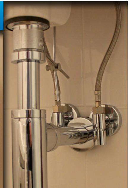
**Bild 3** | Der Zustand von Flexschläuchen muss regelmäßig kontrolliert werden. Nach IFS Erfahrungen bilden sie einen Schadensschwerpunkt.
