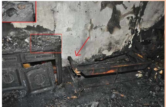
Bild 8 | Im Bereich zwischen Sofa und Schränkchen werden die räumlich tiefsten Brandspuren (Pfeil) festgestellt. Auf dem Schränkchen neben dem Ecksofa werden zwar die gut erhaltenen Überreste einer Häkeldecke gefunden (kleines Bild). Überreste, die auf ein auf der Häkeldecke abgestelltes Grablicht hinweisen, werden nicht mehr festgestellt. Das Grablicht war vermutlich abgestürzt und hat das nebenstehende Sofa entzündet.
