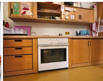
Bild 6 | Risikoklasse 2 Solche Küchenzeilen finden sich in vielen Gruppenräumen. Die Räume selbst verfügen über keinen Bodenablauf. Melder sollten hier unzugänglich an der Wand unter den Wandanschlüssen installiert werden.
