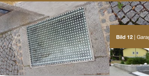
Bild 11 | Permanent verschlossener Lichtschacht mittels dafür geeigneter und abgedichteter Glasplatte.
