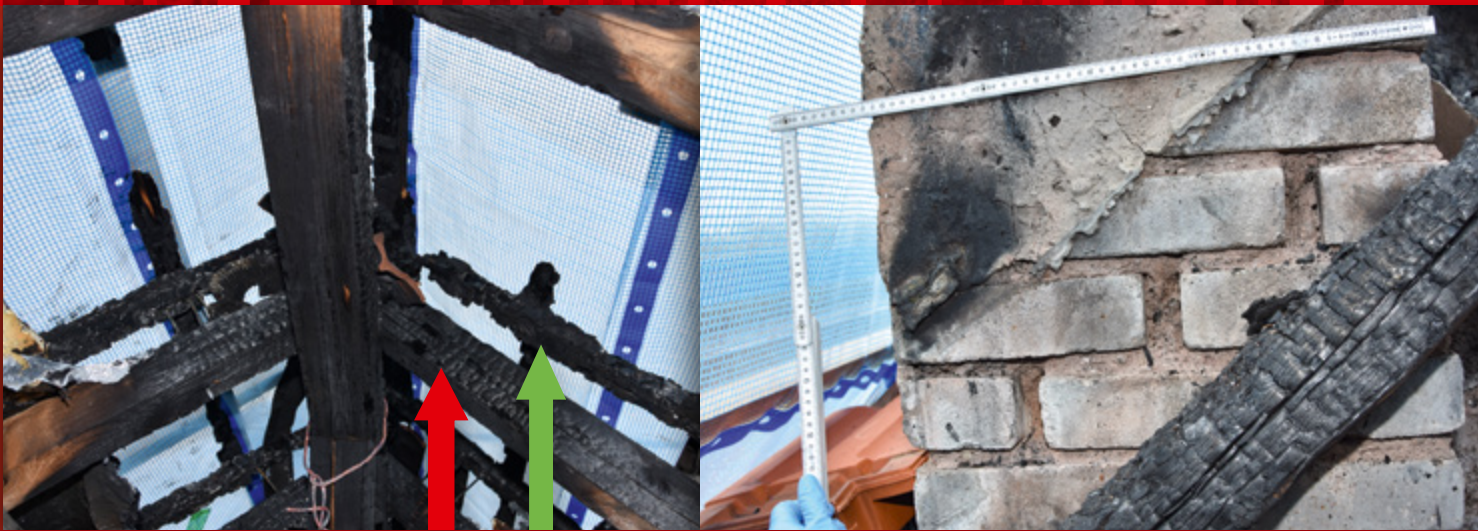
Bild 1 | Auf die Dachsparren (roter Pfeil) wurden im Zuge der Sanierung Dämmplatten und darüber eine Konterlattung (grüner Pfeil) aufgebracht.
