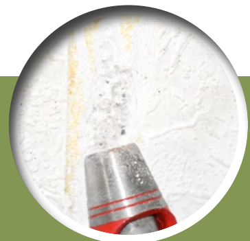
Probenahme einer Spachtelmasse mithilfe des Henkellocheisens
