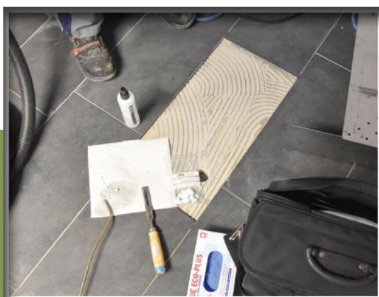
Entnahme einer Materialprobe der Dämmschicht aus dem Bodenaufbau aus einer frisch erstellten Öffnung mithilfe von desinfiziertem Besteck.
