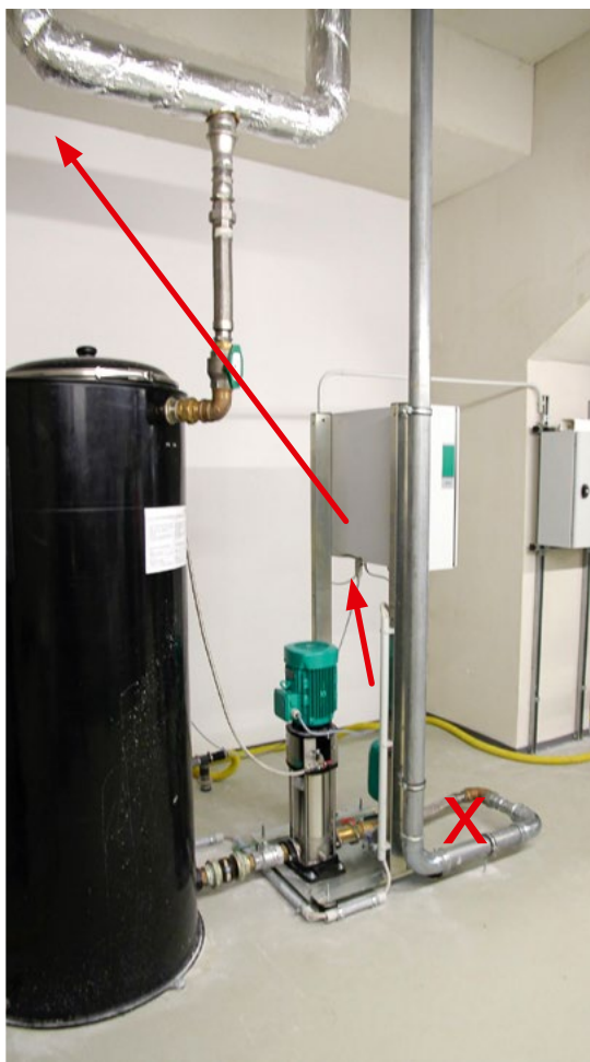
Bild 3 | Von seinem Installationsort an der markierten Stelle ist das Ausdehnungsgefäß zunächst gegen das Gehäuse der Steuerungsanlage und dann gegen die Betondecke geflogen.
