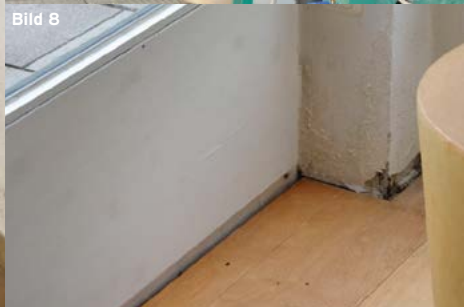
Bild 6 / Fallbeispiel 1: Wasserränder im Treppenhaus des Versorgungszentrums: Hier liegen mehrere Schadensursachen vor. Bild 7 / Durch eine chemische Untersuchung konnte geklärt werden, ob es sich um Leitungswasser oder Wasser aus dieser Entsalzungsanlage handelt. Bild 8 / Fallbeispiel 3: Salzausblühungen im Bereich des Wintergartens. Bild 9 / Fallbeispiel 3: Im Bereich des Wintergartens werden Erdreich (Pfeile) und lebende Ameisen gefunden.
