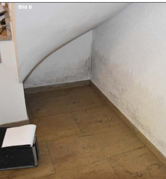
Bild 6 / Fallbeispiel 1: Wasserränder im Treppenhaus des Versorgungszentrums: Hier liegen mehrere Schadensursachen vor. Bild 7 / Durch eine chemische Untersuchung konnte geklärt werden, ob es sich um Leitungswasser oder Wasser aus dieser Entsalzungsanlage handelt. Bild 8 / Fallbeispiel 3: Salzausblühungen im Bereich des Wintergartens. Bild 9 / Fallbeispiel 3: Im Bereich des Wintergartens werden Erdreich (Pfeile) und lebende Ameisen gefunden.
