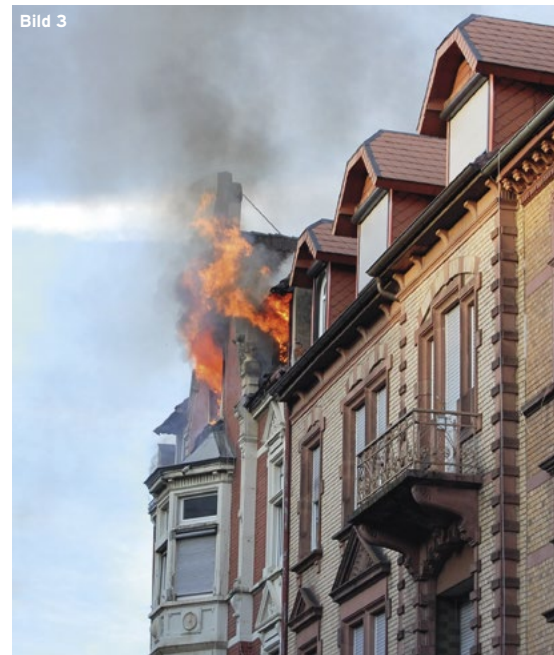
Bild 3 / Der optische Eindruck lässt schon bei Eintreffen darauf schließen, dass in den vom Brand betroffenen Räumen keine Sachwerte mehr zu retten sein werden und der Totalschaden bereits eingetreten ist.
