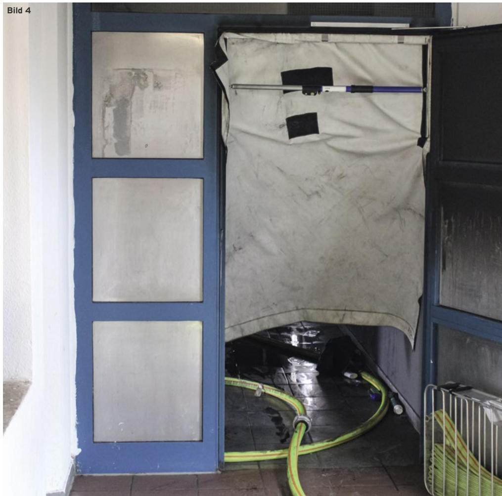
Bild 4 / Der mobile Rauchverschluss ist ein gutes Instrument, um Schadenbereiche einzugrenzen, die Rauchausbreitung zu behindern und Schäden durch Kontamination zu vermeiden.
