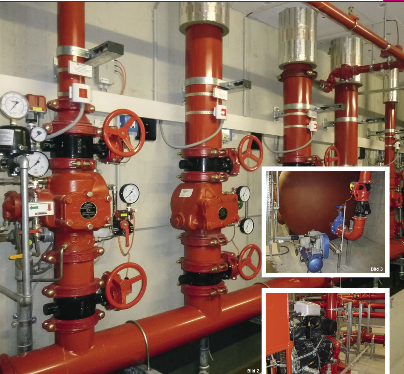
Bild 2 / Alarmventilstation Bild 3 / Druckluftwasserbehälter Bild 4 / Sprinklerpumpe
