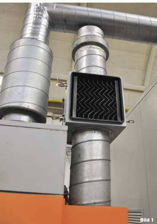
Bild 1 / Einfach konstruierte Funkenlöschscheinrichtung
