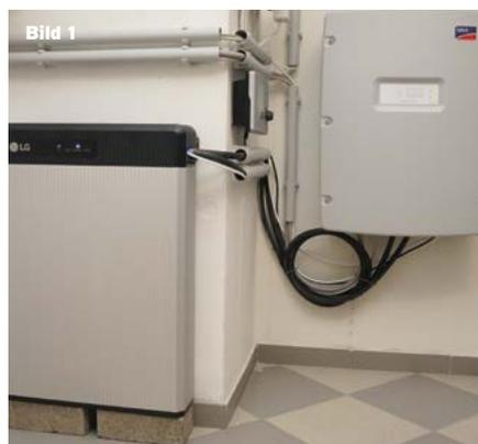
Bild 1 / Lithium-Ionen-Batterie 6,5 kWh
