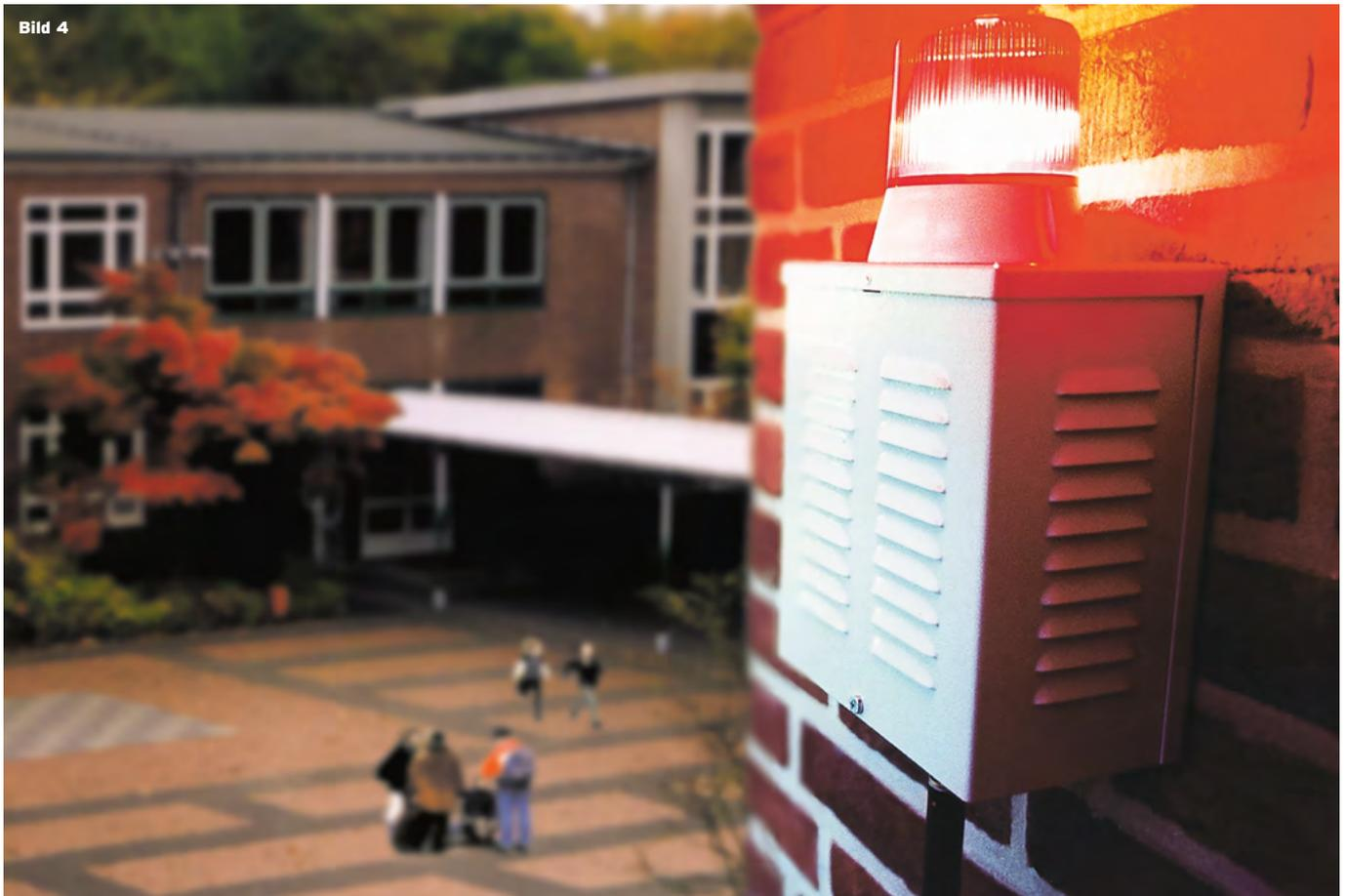
**Bild 4 /** Ein optischer und akustischer Externalalarm erhöht gleich im äußeren Sicherheitsbereich die Entdeckungsgefahr für Täter und „stiehlt“ ihnen die benötigte Zeit.
