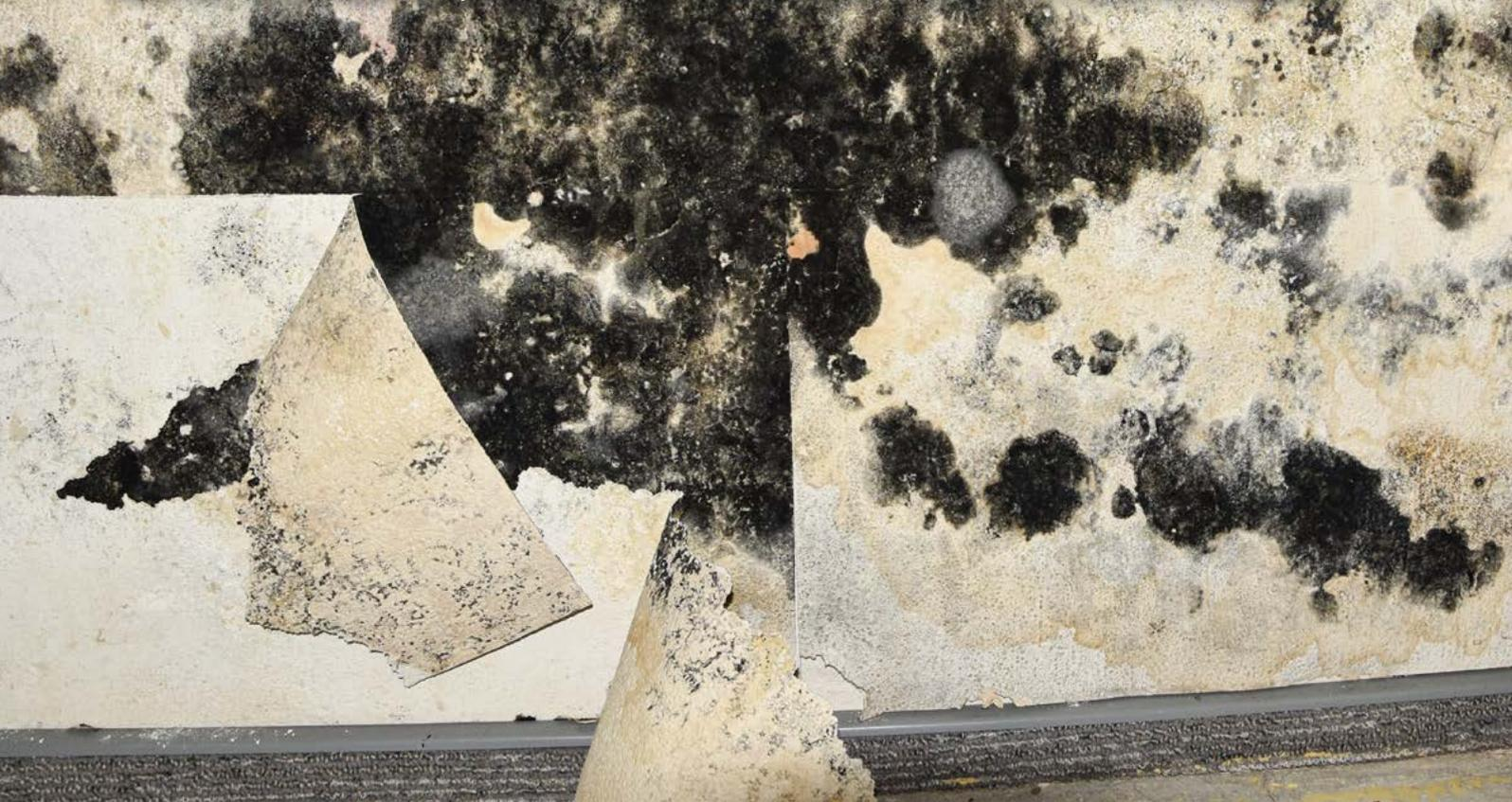
Nachdem im ausgebauten Dachgeschoss eines Reihenhauses Leitungswasser aus einer undichten Duscheinrichtung in die Leichtbauwände gedrungen war, baute ein Fachbetrieb den Fußbodenaufbau und die Gipskartonbeplankungen der Ständerwände teilweise zurück (**Bild 1**).
