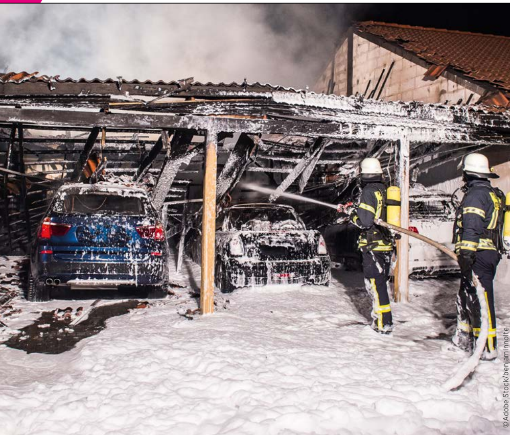
Bild 8 / Durch zunehmende Brandlasten bei modernen PKW kann der Umfang der Brandschäden an umgebenden Bauwerken zunehmen.
