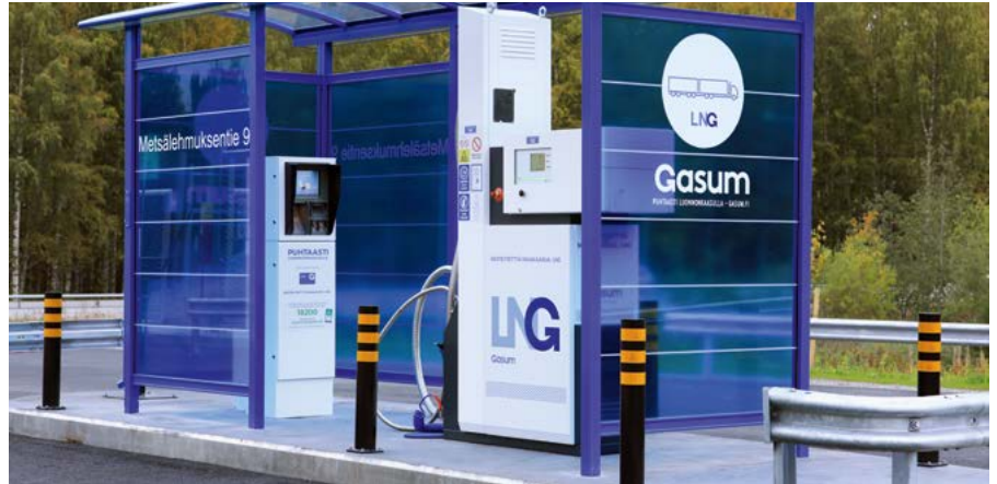
Bild 2 / Der Ausbau eines Tankstellennetzes zum Nachfüllen des tiefkalt verflüssigten Erdgases ist eine Voraussetzung für den Betrieb der LNG-LKW.
