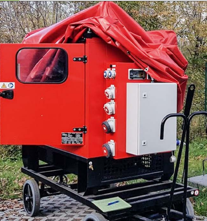
Bild 4 / Ortsveränderliches Notstromaggregat einer Feuerwache (Foto: Berliner Feuerwehr)
